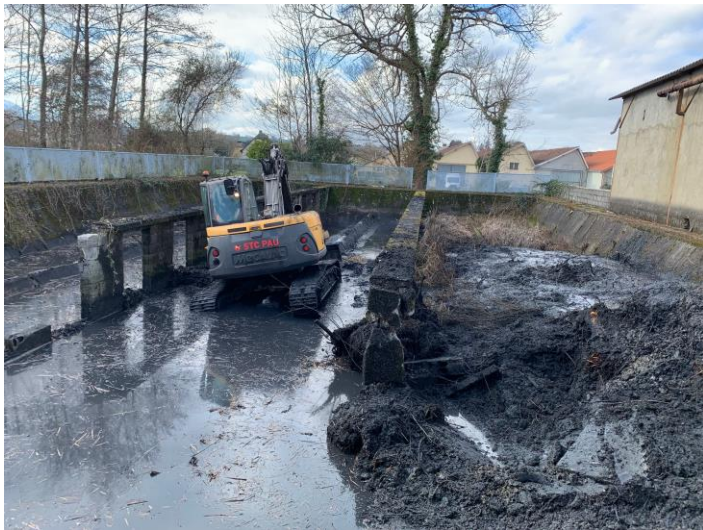
Travaux de mise en sécurité
